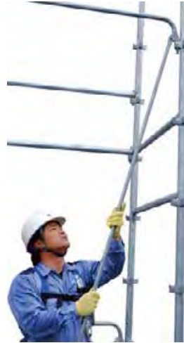
先行手すり方式のため、安全に設置できます。
