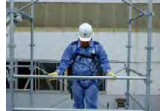
布材は3ステップで取付け完了
