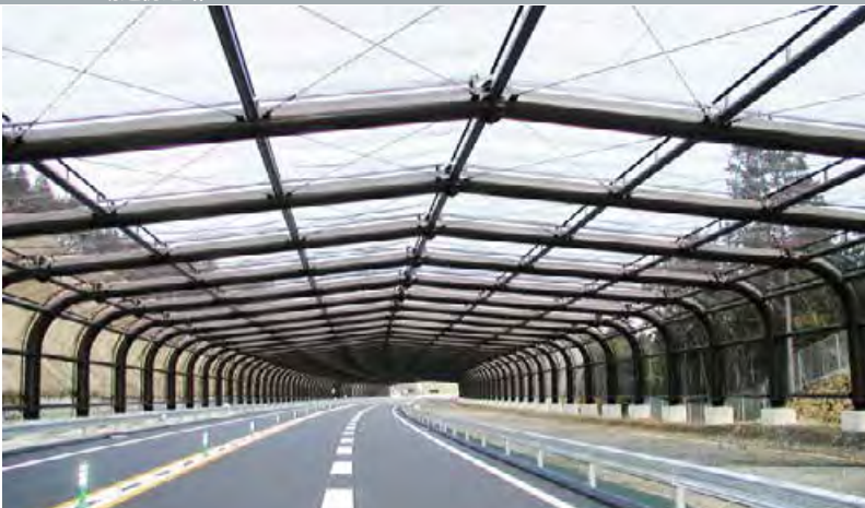
鋼管やH鋼によるアーチで、道路上空を覆う堅固なシェルターです。 軽量、短尺な部材で構成されており、狭小な現場でも施工が容易です。
